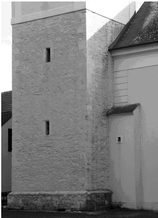
Natursteinmauer des Altbaues aus dem 11./12. Jahrhundert
