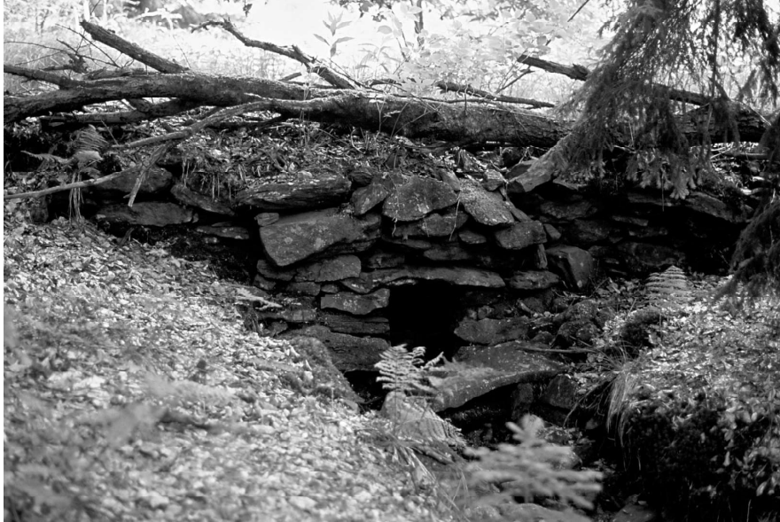
Abb. 22: Brücke mit Wasserdurchlass
