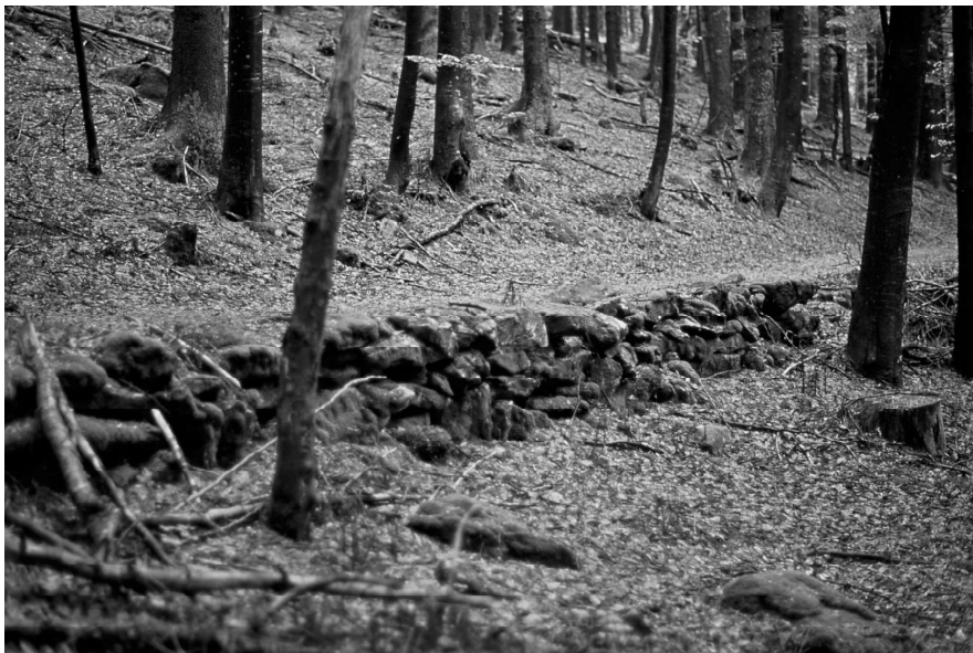
Abb. 21: Stützmauer des Breitenauer Weges
