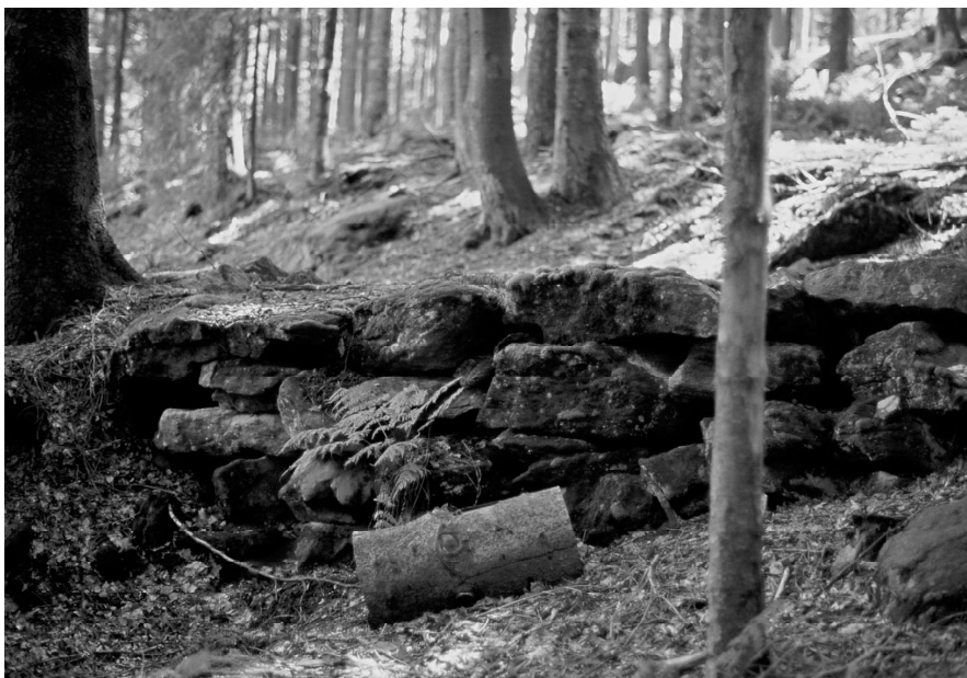
Abb. 10: Ansicht der Stützmauer am Sommerweg
