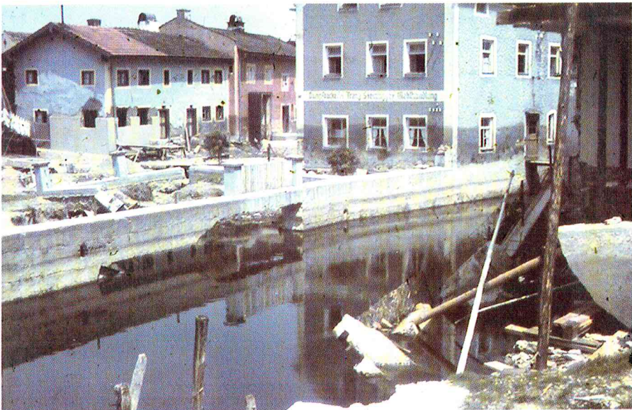
Abb. 18: Am Mühlbach und in der Mühlbachstraße bot sich nach Ablauf des Hochwassers ein Bild der Verwüstung. An den Hauswänden kann noch immer der Wasserstand abgelesen werden.
