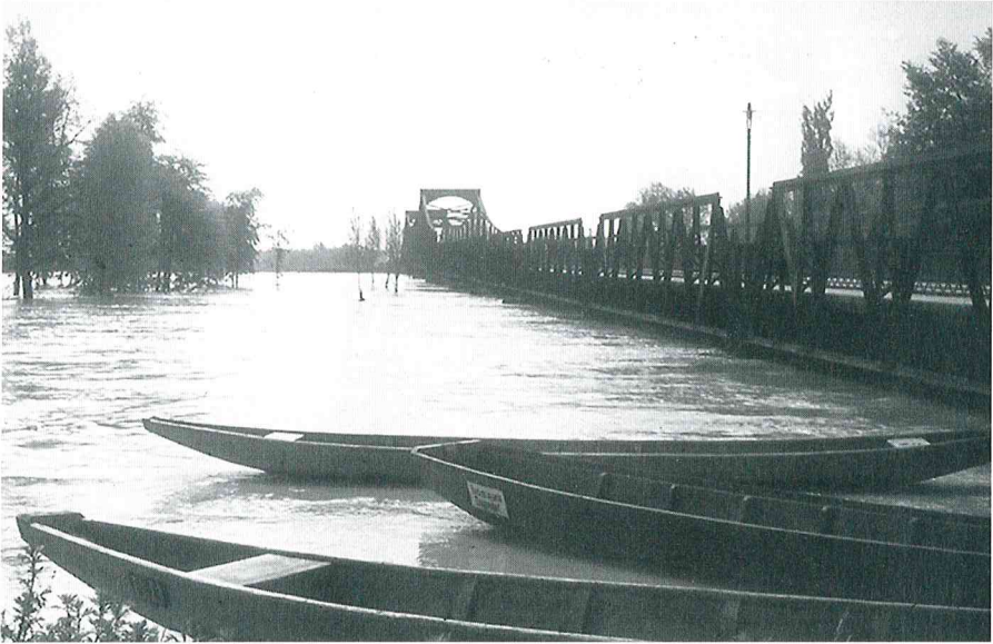
Abb. 1: Das Hochwasser steht an der Plattlinger Isarbrücke bis fast zur Brückenunterkante an. Das Bild zeigt die Albrechtbrücke in ihrem ursprünglichen Bauzustand, als es noch keine außen montierten Gehwege gab.
