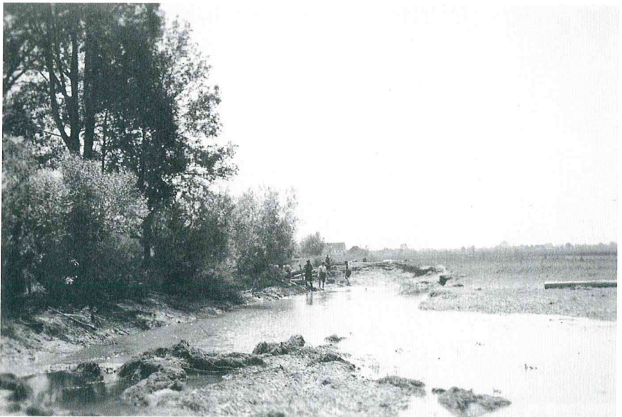
Abb. 4: Bei Schiltorn brach der Damm ebenfalls am 2. Juni 1940 auf 60 Meter Länge auf.
