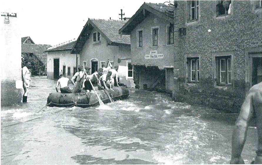
Abb. 13: Ecke Ludwigplatz–Järgasse. Das Eckl-Haus, in dem sich eine Schleiferei und ein Schirmgeschäft befanden, drohte einzustürzen. Es konnte jedoch durch Stützmaßnahmen der Wehrmacht erhalten werden.
