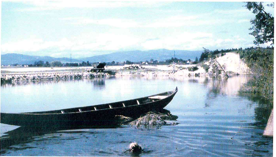
Abb. 24: Der Dambruch bei Pielweich nach Ablauf des Hochwassers. Die Fluten haben dort ca. 10000 Kubikmeter Material abgeschwemmt und ein 7 Meter tiefes Loch hinterlassen. In der Bildmitte ist eine Feldbahn zu sehen, die zum Transport der zur Schadensbehebung erheblichen Materialmengen eingesetzt wurde.
