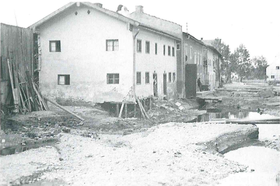
Abb. 22: Die Mühlbachstraße war komplett weggespült, die Häuser zum Teil unterspült und einsturzfähig.
