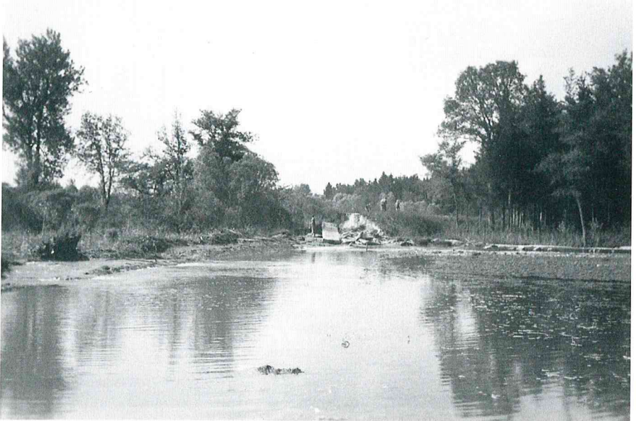
Abb. 3: Der Dambruch bei Neutiefenweg am 2. Juni 1940 hat dort ein 220 Meter langes Loch hinterlassen.
