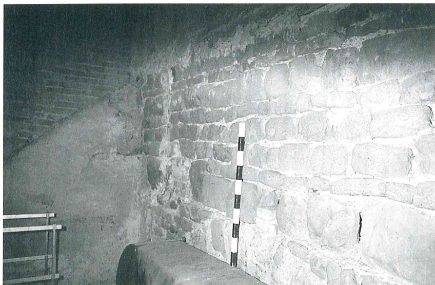
Abb. 2: Künzing-St. Laurentius. Romanische Südwand des Hauptschiffs oberhalb des südwestlichen „Anbaues“. Am unteren Bildrand ist oberhalb des Metallkastens eine Arkade der ehemaligen Basilika zu erkennen, am oberen Bildrand der Verputzabdruck des ehemaligen Seitenschiffdaches, im Hintergrund die verputzte Westwand (Dachschräge) des ehemaligen Seitenschiffes (K. Schmotz, 18.9.2003).
