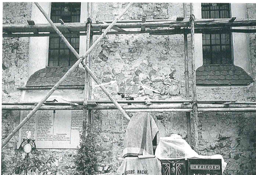
Abb. 12: Künzing-St. Laurentius. Detail der Nordwand mit zwei Arkadenansätzen (W. Haas, Bayer. Landesamt für Denkmalpflege, 1968).
