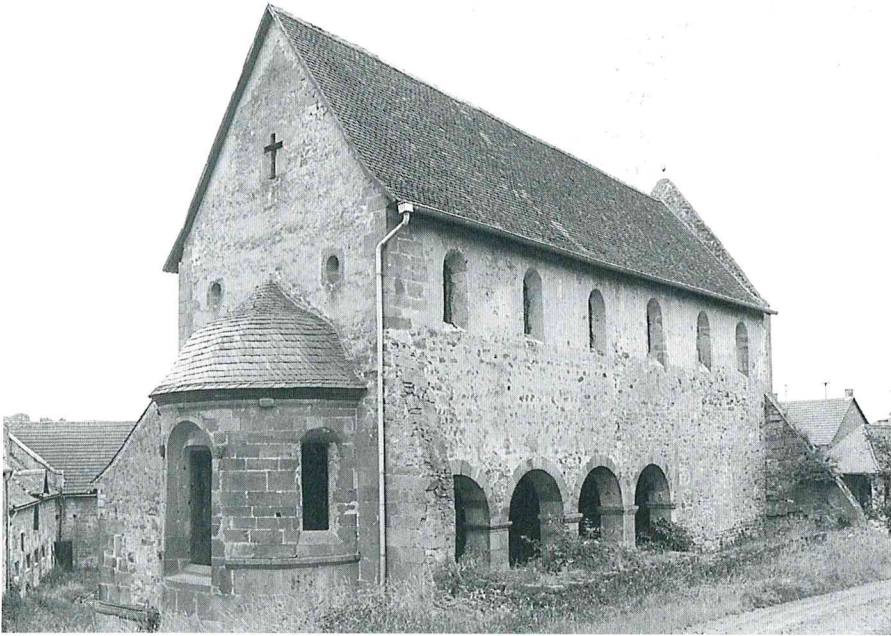
Abb. 21: Ortenberg-Konradsdorf (Hessen). Romanische Basilika mit fehlendem (Zerstörung im Dreißigjährigen Krieg) nördlichem Seitenschiff (Landesamt für Denkmalpflege Hessen).
