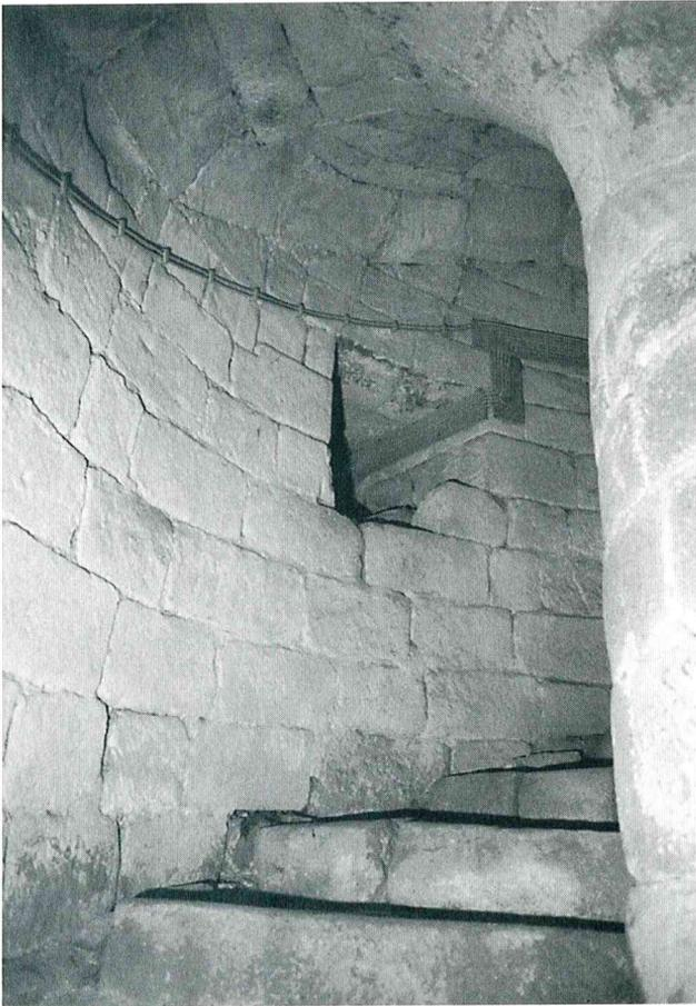
Abb. 3: Metten. Wendeltreppe im Untergeschoss des Nordturms (Foto: Schmotz 5.7.2001).
