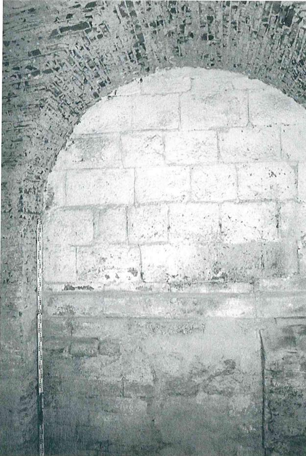
Abb. 8: Metten. Romanisches Mauerwerk an der Nordwand der Nordturmes während der Umbauten für die Einrichtung der Benediktuskapelle (Foto: Schmotz 23.4.1997).
