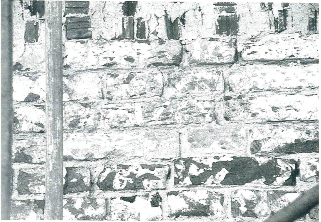
Abb. 12: Bachling – St. Stephan. Langhaus-Nordwand mit verstümmelten Mustern aus weißer Kalkschlämme.
