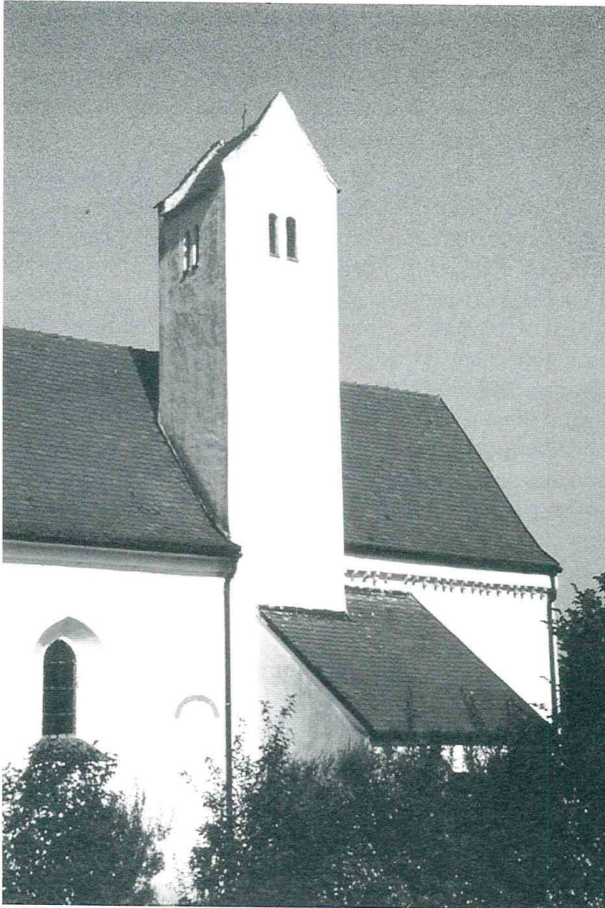
Abb. 26: Gneiding (Gde. Oberpörling, Lkr. Deggendorf) – St. Si- mon und Judas. In den In- nenraum zwischen Langhaus und Altarraum eingestellter Turm (3.10.1995).
