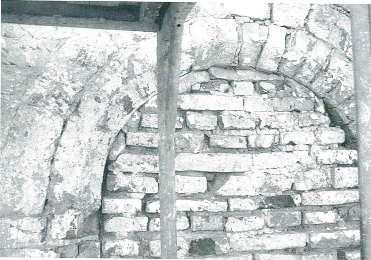
Abb. 11: Bachling – St. Stephan. Bogen aus abgefasten Formziegeln über dem romanischen Portal (vgl. Abb. 5, H).
