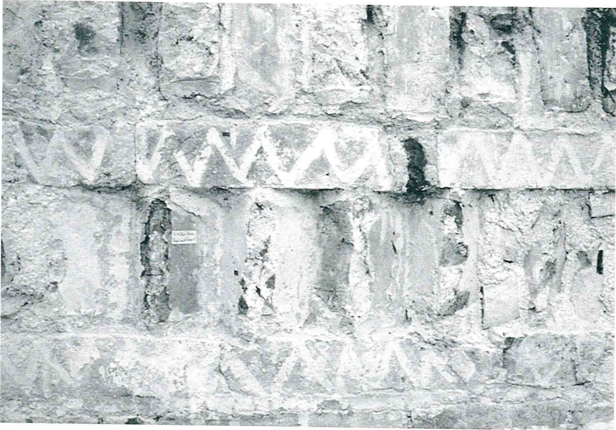
Abb. 7: Bachling – St. Stephan. Altarraum-Südwand. Deutsches Band, darüber abgeschlagene Konsolsteine und begleitendes Zick-Zack-Muster.
