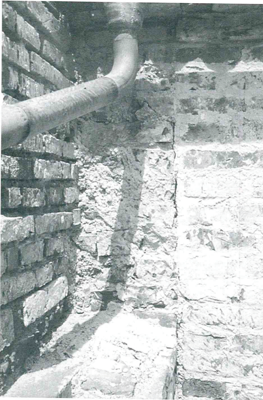
Abb. 6: Bachling – St. Stephan. Mau- errücksprung am südlichen Übergang von Langhaus zu Altarraum und Baufuge am Altarraum (vgl. Abb. 3, F).
