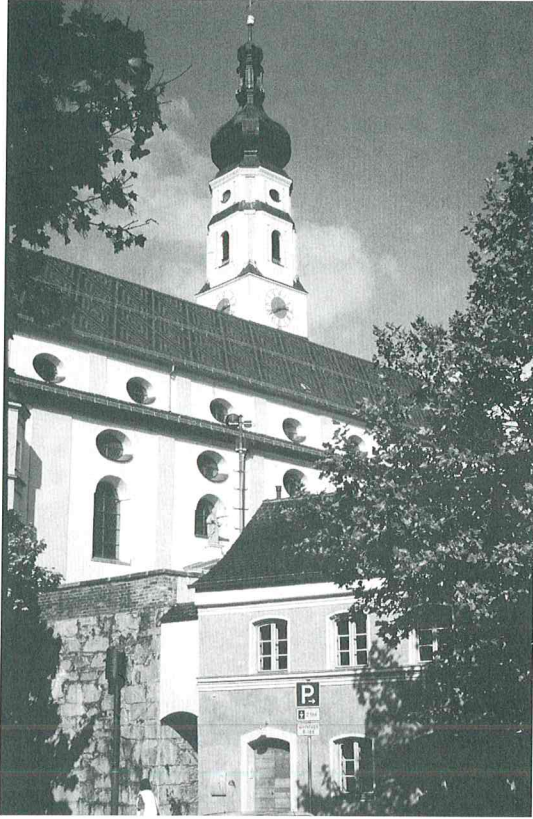
Abb. 1: Deggendorf – Hengersberger Straße 1. Das in die Stützmauer des Friedhofes eingebundene Gebäude beherbergte im 15. Jahrhundert eine 1993 wiederentdeckte Paternoster-Werkstatt (6. 10. 1996).
