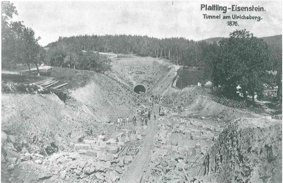
Die Bauarbeiten im Kühberg-Kehrtunnel waren im Sommer 1876 bereits weitgehend abgeschlossen. Unzählige Arbeiter waren jedoch noch am Einschnitt des Südportals beschäftigt. Eine Lorenbahn erleichterte den Abraumtransport aus dem Einschnitt. Aus den Granitquadern im Vordergrund entstand eine Straßenüberführung. Quelle: Archiv des Verkehrsmuseums Nürnberg
