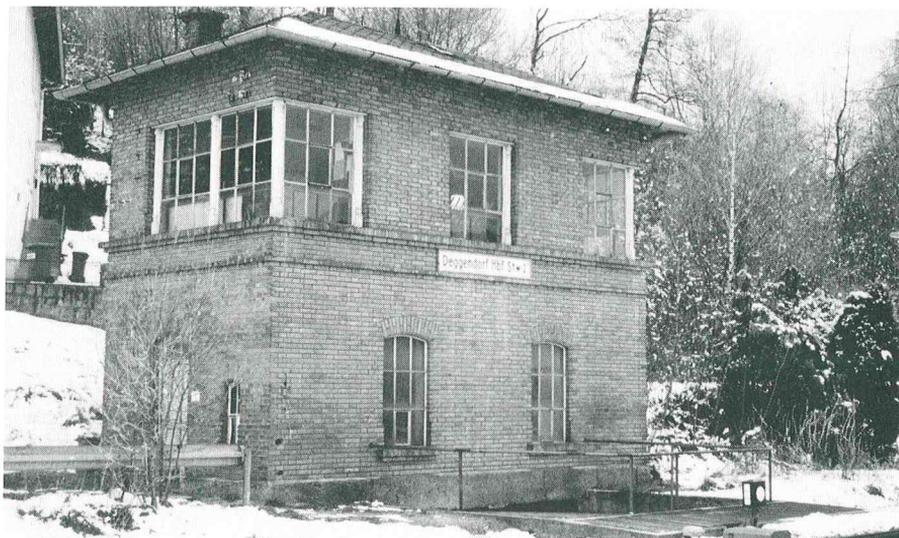
Die Handbedienung der Weichen und Signale vor Ort hatte ein Ende mit dem Bau zentraler Stellwerkseinrichtungen im Jahr 1906. Von nun an regelten im Empfangsgebäude der Fahrdienstleiter am Befehlsstellwerk und an den Bahnhofsausfahrten je ein Stellwerker in einem Wärterstellwerk den Fahrbetrieb. Das Bild zeigt das Wärterstellwerk an der Ulrichsberger Ausfahrt. Wenige Tage nach der Außerdienststellung am 26. November 1991 fiel das Backsteingebäude der Spitzhacke zum Opfer.
