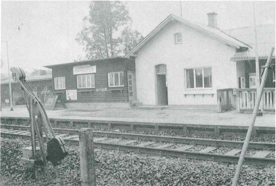
Im Jahre 1938 erfuhren die Pankofener Bahnanlagen eine wesentliche Erweiterung. Das Betriebsgebäude bekam einen holzverschalteten Anbau, der das Befehlsstellwerk des Fahrdienstleiters beherbergte (Gebäudetrakt mit Bahnhofsschild). Das links nach hinten versetzte Gebäude wurde ebenfalls 1938 errichtet. Es umfaßte einen Lagerraum für Stückgut, Toiletten und Geräteunterstände.
