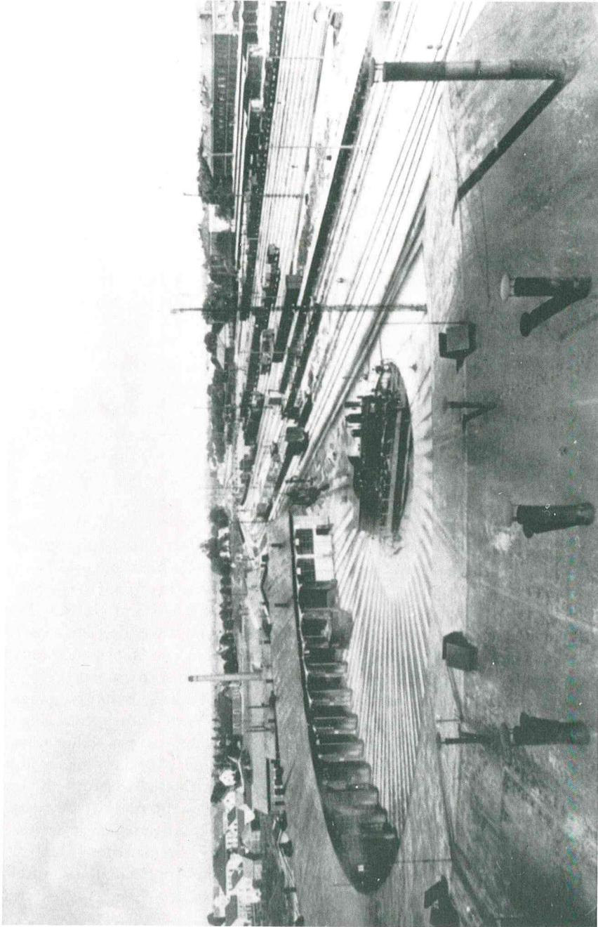
Eine besondere Rarität stelle diese Übersichtsaufnahme aus dem Jahr 1905/06 dar. Im Vordergrund der östliche Rundschuppen mit 28 Stränden, der nach den Kriegserstörungen nicht mehr aufgebaut wurde. Auf der Drehscheibe posiert eine Güterzuglok der Gattung CIV der Königl. Bayer. Staatsbahn. Rechts im Hintergrund das Empfangsgebäude. Die Bahnanlagen überspannt der „Eiserne Steg“: Foto: Archiv Ludwig Börner, Plattling
