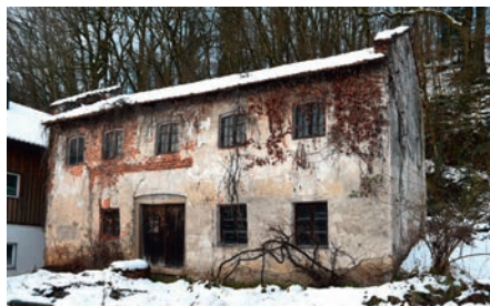
Die Dorfschmiede Offenberg im Jahre 2014 vor der Instandsetzung (Roland Binder)
