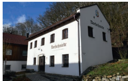
Das Gebäude nach der Maßnahme (Roland Binder 2018)
