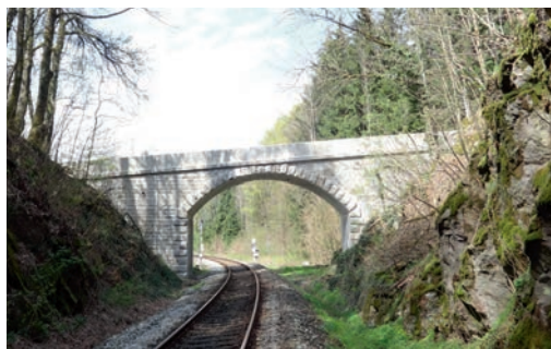
Das Bauwerk nach der Maßnahme (Jakob Denk 2015)
