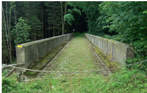
Die Bahnbrücke bei Arzting vor der Sanierung (Hans Moosbauer 2012)
