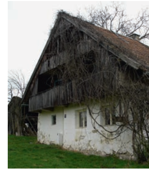
Das Mitterstallhaus auf dem Riedfeld (Markt Metten) vor der Instandsetzung (Florian Jung 2010)
