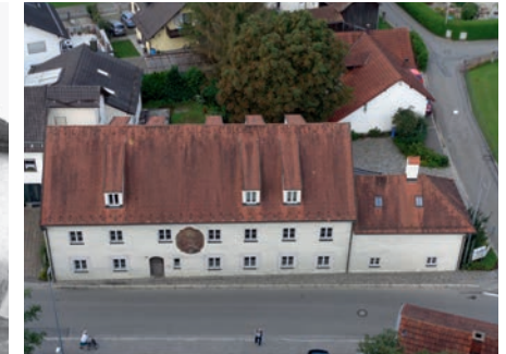
Das in der Mitte der 1990er Jahre instand gesetzte Gebäude (Florian Jung 2017)
