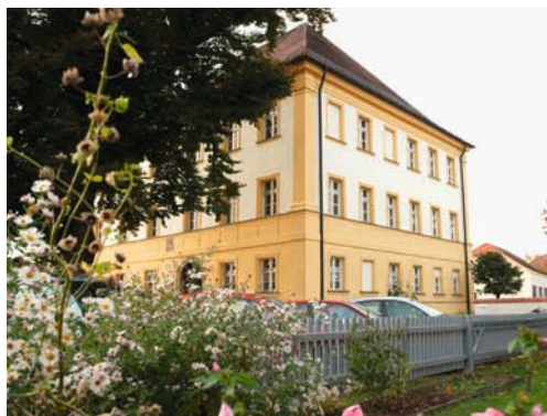
Abb. 10: Altbau der Abt-Joscio-Schule (ehemaliges Hofrichterhaus) 2005 nach der Renovierung
