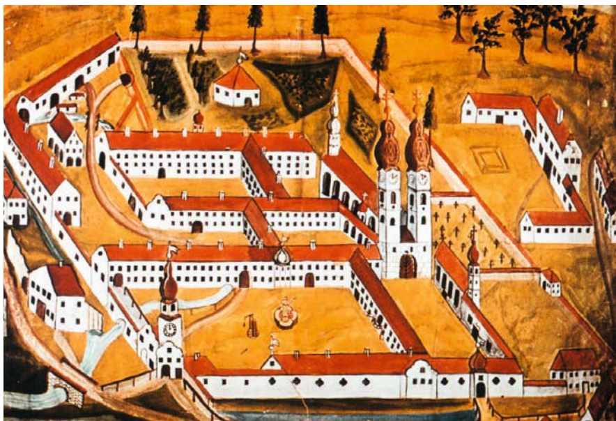
Abb. 1: Die Benediktinerabtei Niederaltaich, eine von zwei erhaltenen Ansichten des originalen Baubestands, zweite Hälfte 18. Jahrhundert. Die andere, wohl ältere Ansicht findet sich im Beitrag von P. Winkler in diesem Heft. (Archiv Abtei Niederaltaich)
