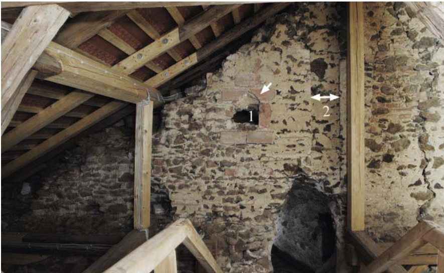
Abb. 2: 2. Obergeschoss des Palas, Ostwand, Innenseite mit südlichem Fenster (1) und Abdruck des südlichen Eckständers (2) der Bohlenstube. Darunter moderner Wanddurchbruch
