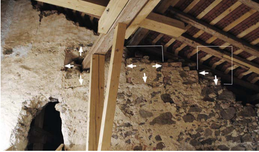
Abb. 3: 2. Obergeschoss des Palas, Ostwand, Außenseite mit den drei Fenstern der Bohlenstube
